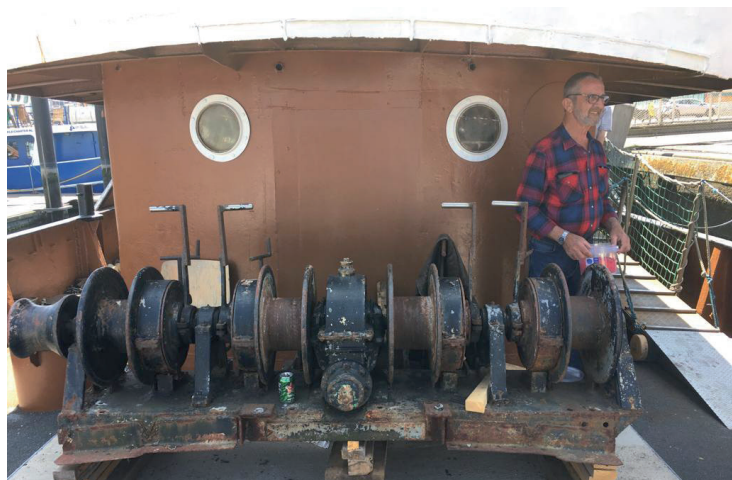
winch voor de brug
