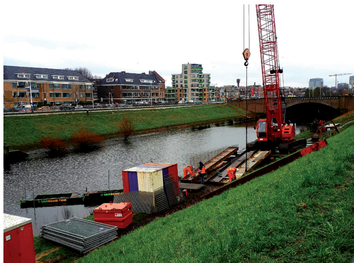
Constructiewerkzaamheden aanleg Aalriffen in Verversingskanaal (foto: Johan van der Harst)
