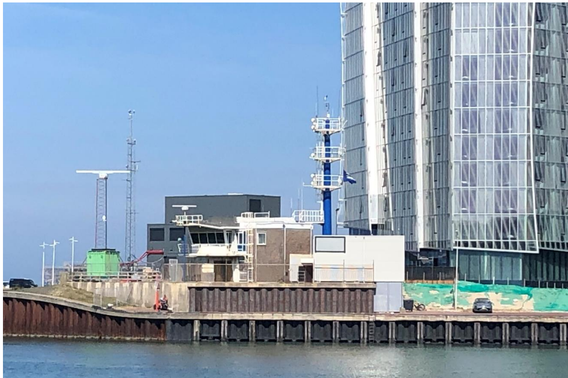
Situatie april- mei 2022 van links naar rechts, tijdelijke (radar)masten, de tijdelijke huisvesting, de oude semafoor (nu gesloopt), oude (radar)mast (verwijderd, in opslag).
