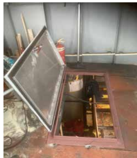
toegangsluik in vloer
