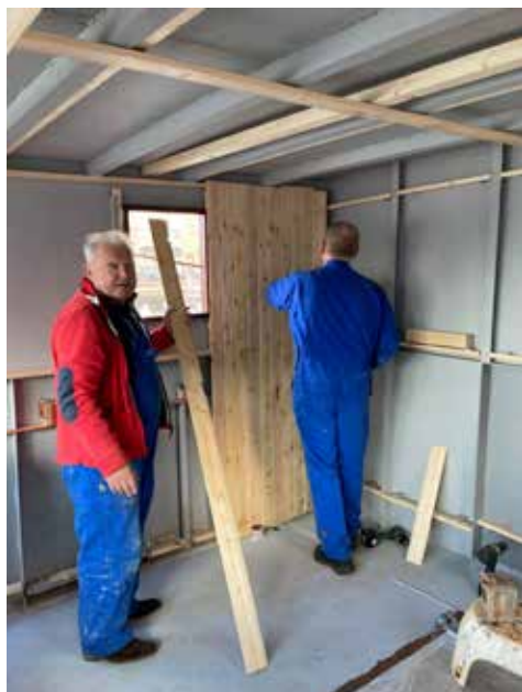
begin gemaakt met betimmering in schippershut
